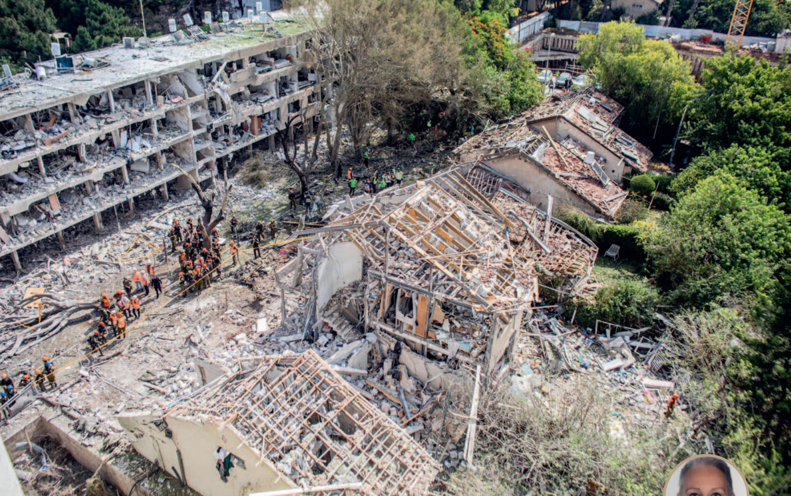
Die Einschlagstelle in Tel Aviv nach einem iranischen Raketenangriff am 22. Juni 2025.
